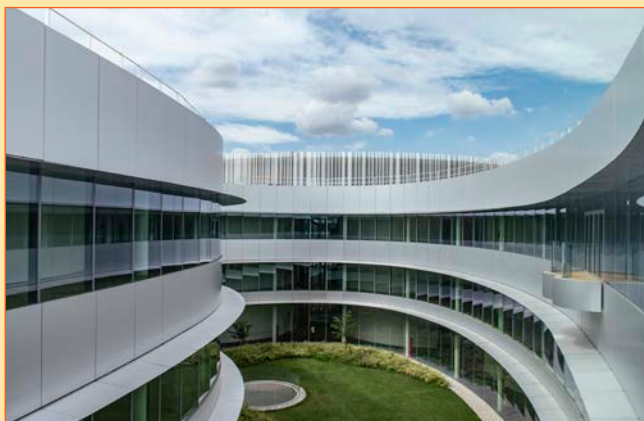
NUOVO CAMPUS DELL'UNIVERSITA' BOCCONI, INAUGURATO NEL 2019
